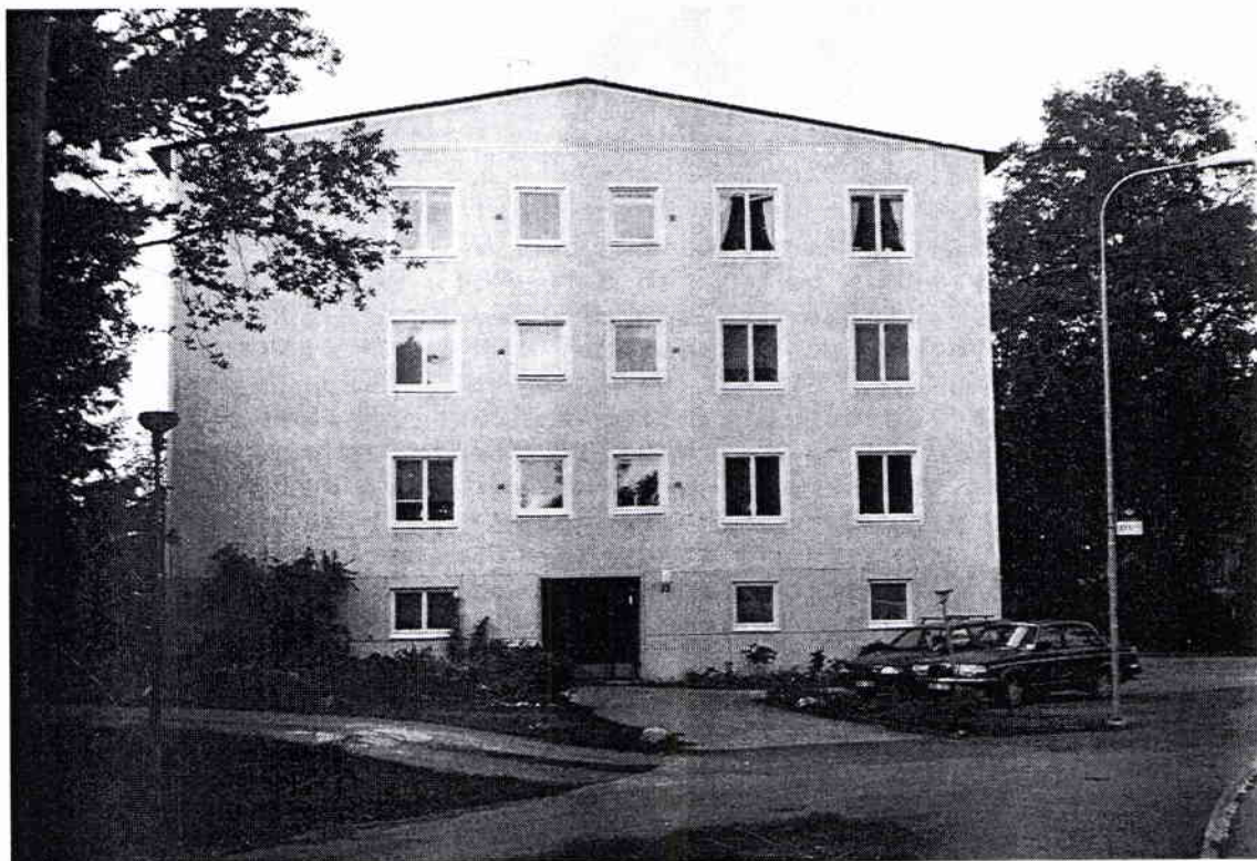
Torshallen 2. Ett av de rosa husen ovan Broberget.
