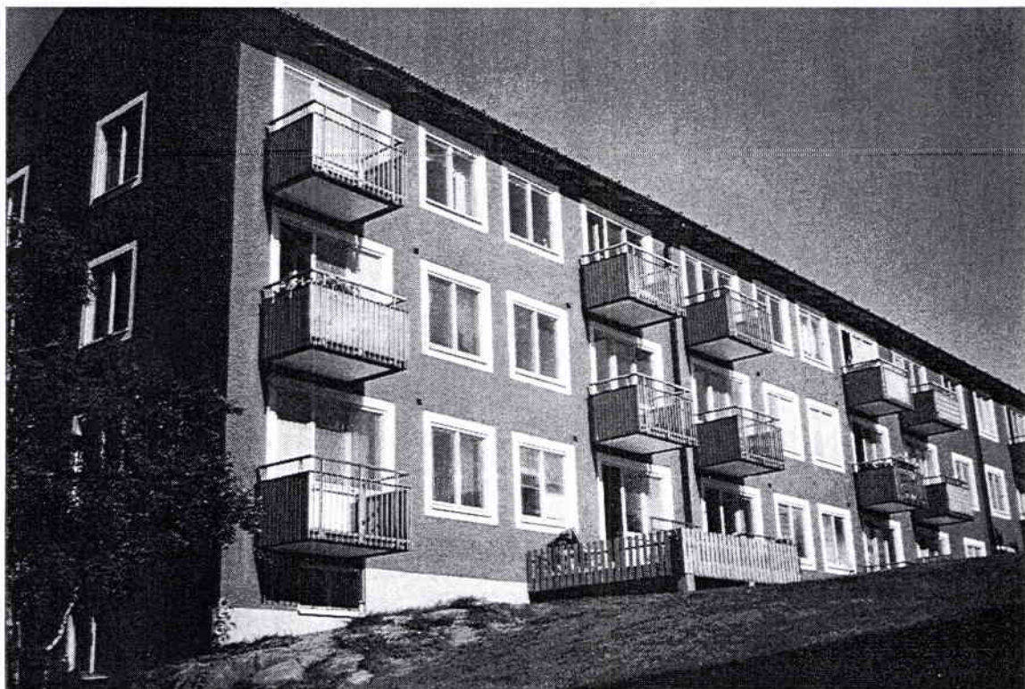
Ett av lamellhusen med iordningställd uteplats.
