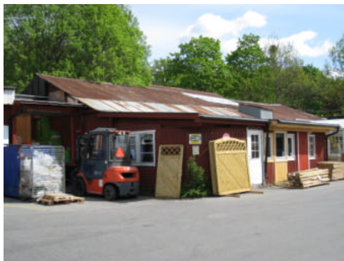
Hus K med för kvarteret karakteristiskt korrugerat plåttak. Tillbyggnaden mot söder har pulpettak.
