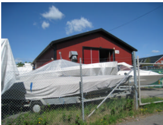
Hus F sett från Brädgårdsvägen.
