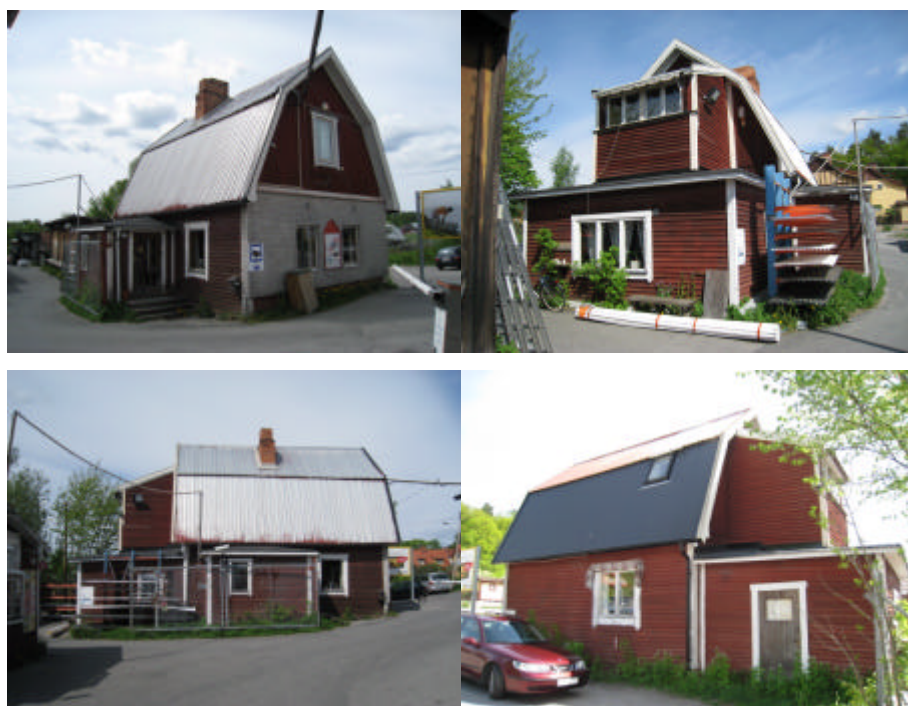
Hus Q har genomgått kraftiga om- och tillbyggnader.
