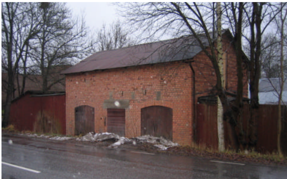
Hus L. Från Elfviksvägen sluttar marken mot fasaden.
