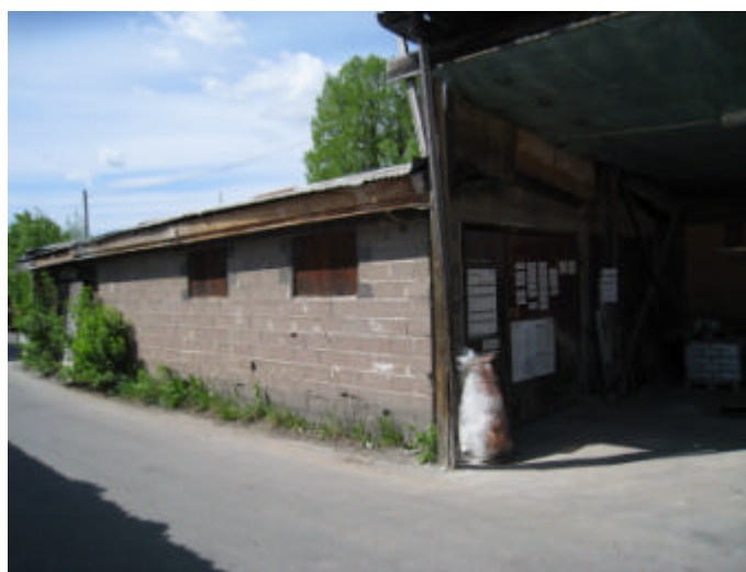
Hus O, södra delen. Lastbilsgaraget med oputsat murverk.
