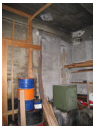
Ovan: Hus L. Interiör med gjutet bjälklag.
