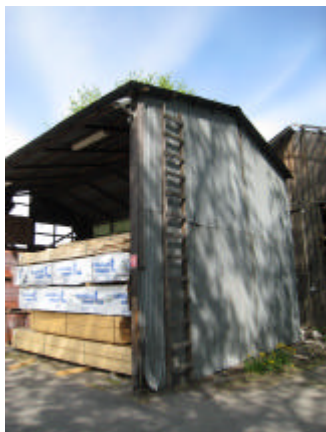
Hus M. Fristående virkesställ vid södra gaveln.
