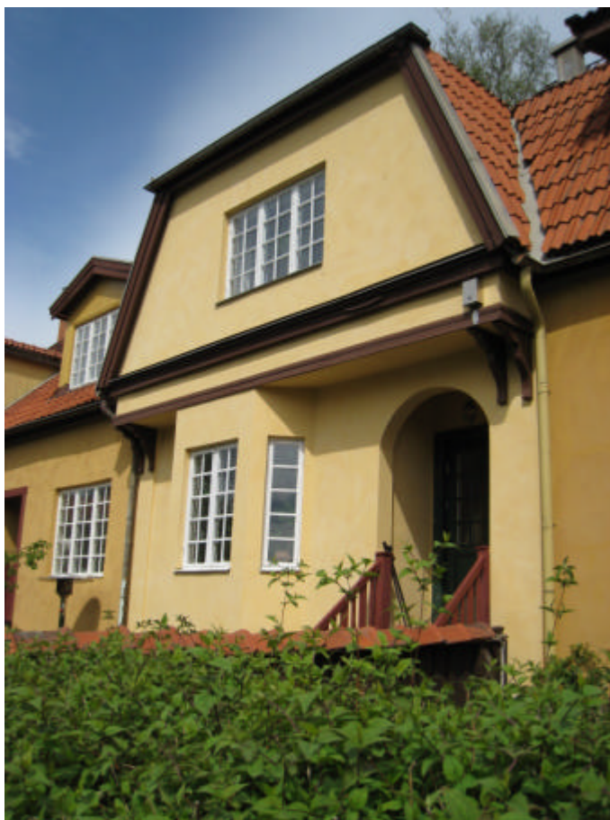
Lidingö 5:35 är fasadrestaurerad enligt länsstyrelsens anvisningar
