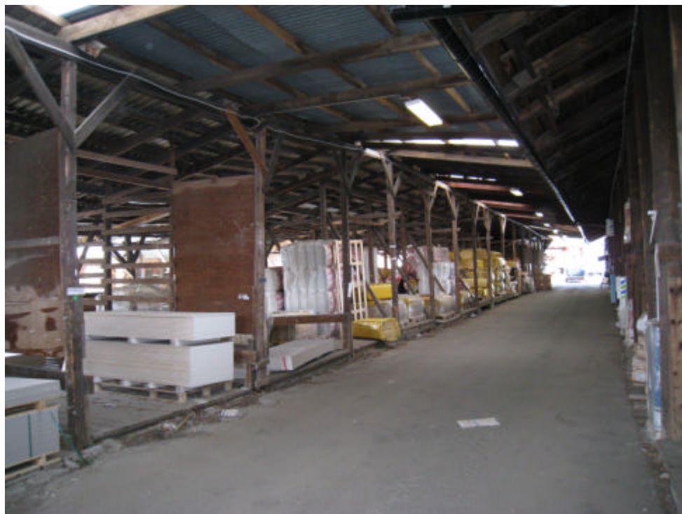
Hus N. Virkeshallens inre är öppet. En lastgata leder genom byggnaden.
