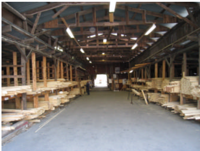
Hus M. Interiör från norr mot söder.
