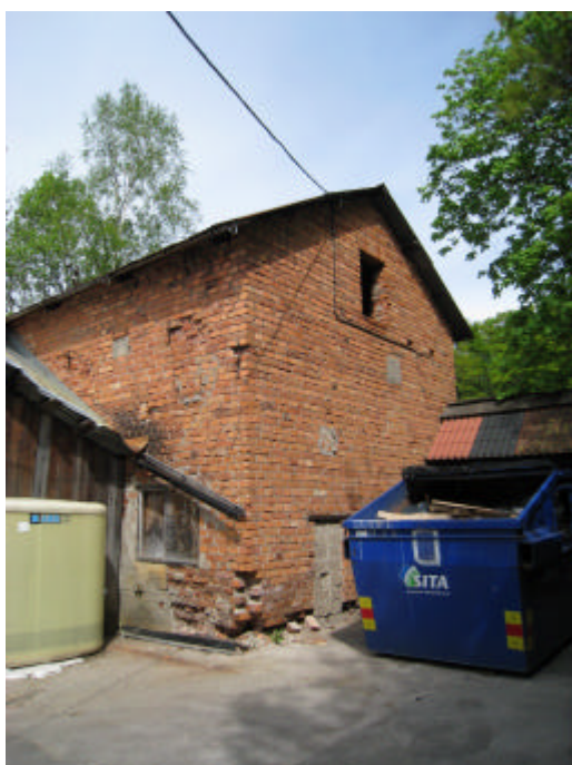
T v: Hus L. Murverket är på vissa håll frostsakat.
