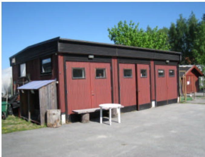
Hus B i förgrunden och A skymtar i höger bildkant.
