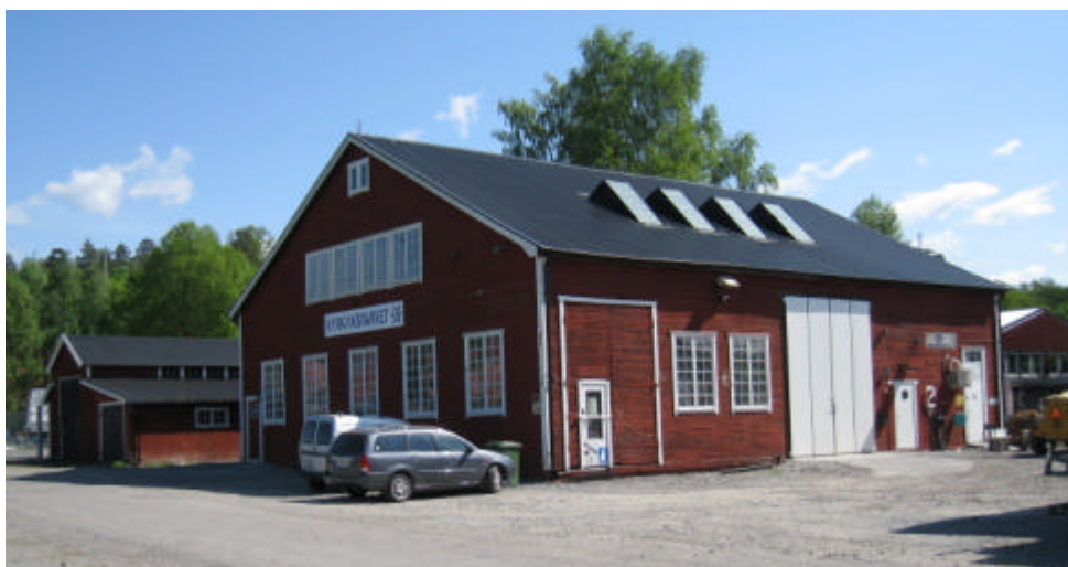
Hus H sett från sydväst med hus I till vänster.
