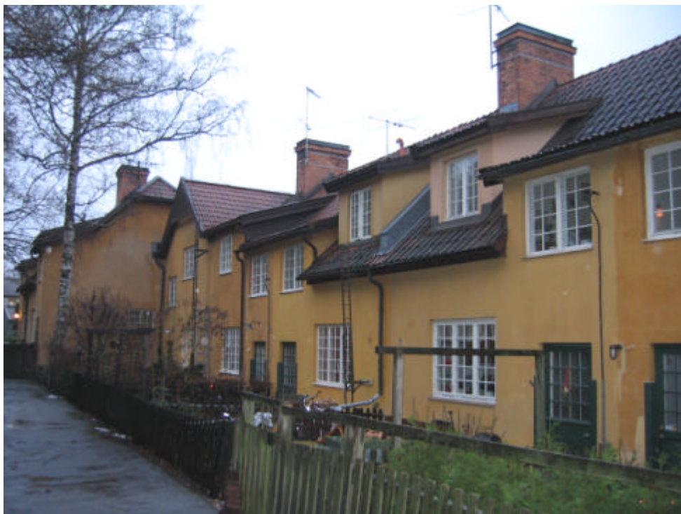
Fasader mot Radstigen.
