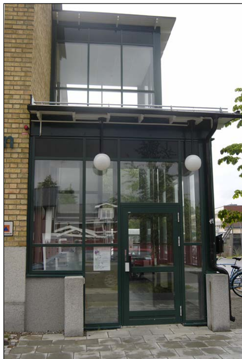
Det nya entrépartiet från öster. Närmast i bild entrén, det högre partiet bakom detta rymmer hisschaktet. Nbm acc.nr 2005:219:16
