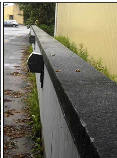
Muren som löper längs tomtens västra gräns. Nbm acc.nr 2005:219:10
