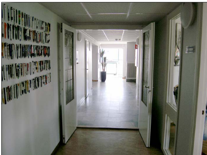
Nedan till höger: Korridor och hall på övre plan. Pardörrar är ursprungliga. Till höger skimtar den öppna spisen i det före detta finrummet. Foto från söder. Nbm acc.nr 2005:220:26
