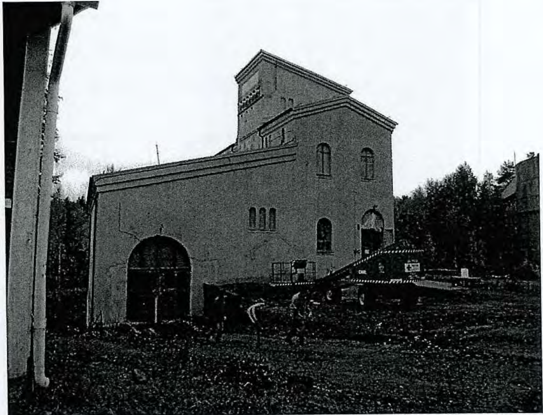
Byggnaden sedd från "gårdsidan" under pågående restaurering. Byggnadens avtrappade volymer speglar de olika funktionerna; de stora portarna leder till maskinsalen, genom den mindre porten når man entresolplanets kontrollrum och i tornet är högspänningsställverket inrymt. Till höger skimtar svalltornet. Foto Jennie Sjöholm© Norrbottens museum. Acc.nr 2006-390-30.
