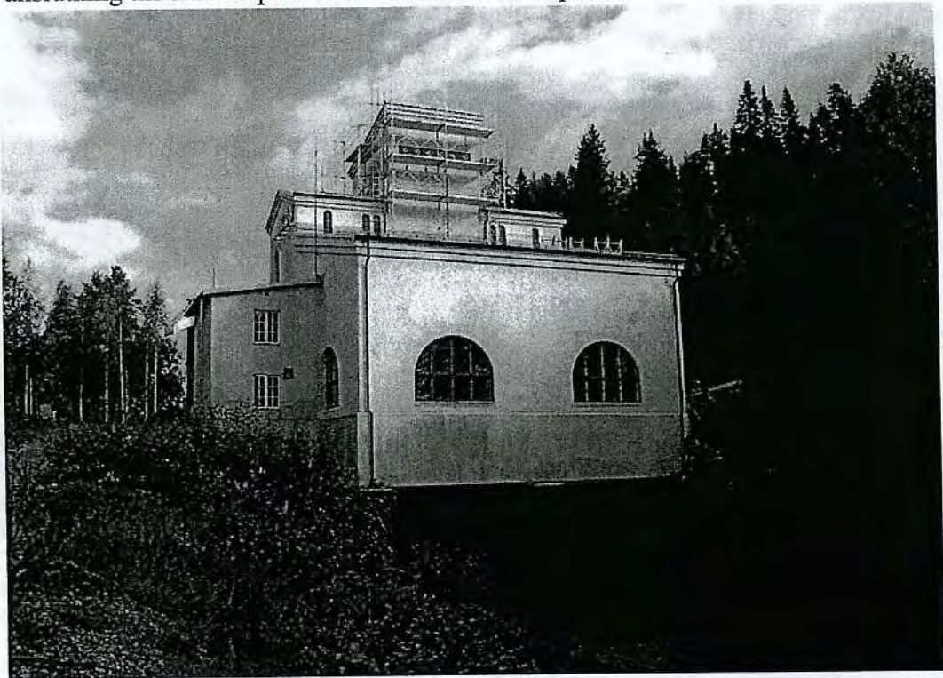
Kraftstationen sedd från utloppsviden. Den tillbyggda delen till vänster. Foto Jennie Sjöholm© Norrbottens museum.Acc.2007-325-28.
