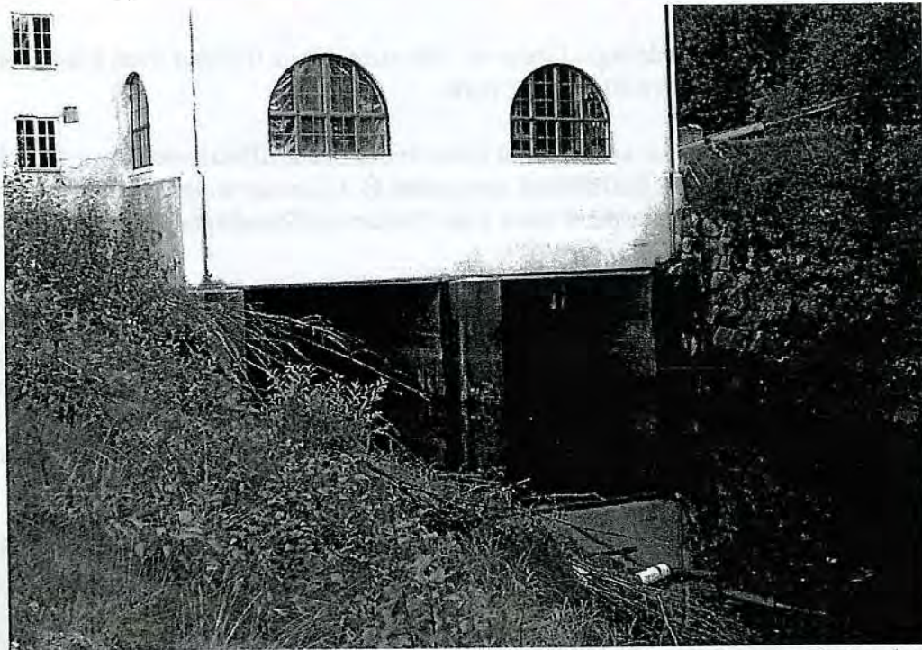
Utloppet genom betongtunnlar under stationsbyggnaden som mynnar i stenskodd kanal vid sidan om älvfäran. Foto Jennie Sjöholm© Norrbottens museum. acc.nr 2007-325-29
