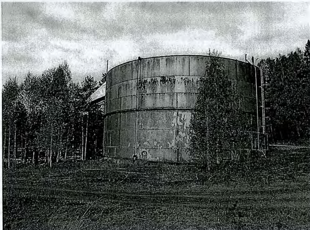
Svalltornet mellan dammen och kraftstationen. Foto Jennie Sjöholm© Norrbottens museum. Acc.nr 2006-374-01.
