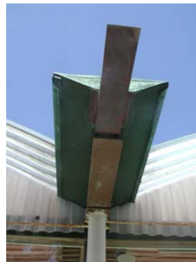
De symmetriskt placerade järnstolparna kröns av vattenutkastare i kopparplåt Foto: Hans Bergfast
