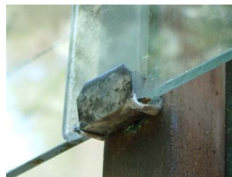
Detalj: glasrutorna hålls på plats med enkla medel
