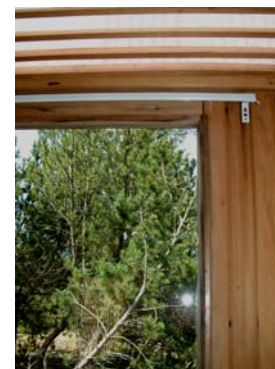
Fönster mot norr. Smäcker fönsterbåge i den tunna väggen.
