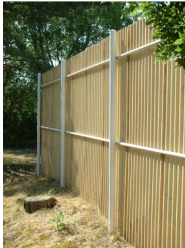
Den korrugerade plasten är monterad på ett enkelt ramverk av järnrör
