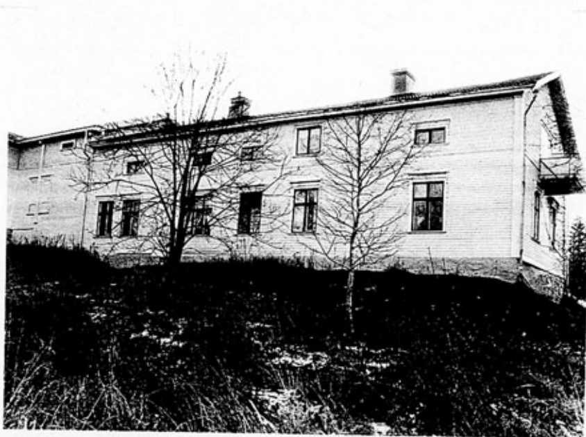
Flygelbyggnaden. Del av norra fasaden (K5401:31)
