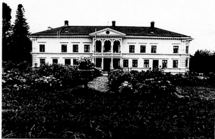
Fasaden mot öster (K5242:30)
