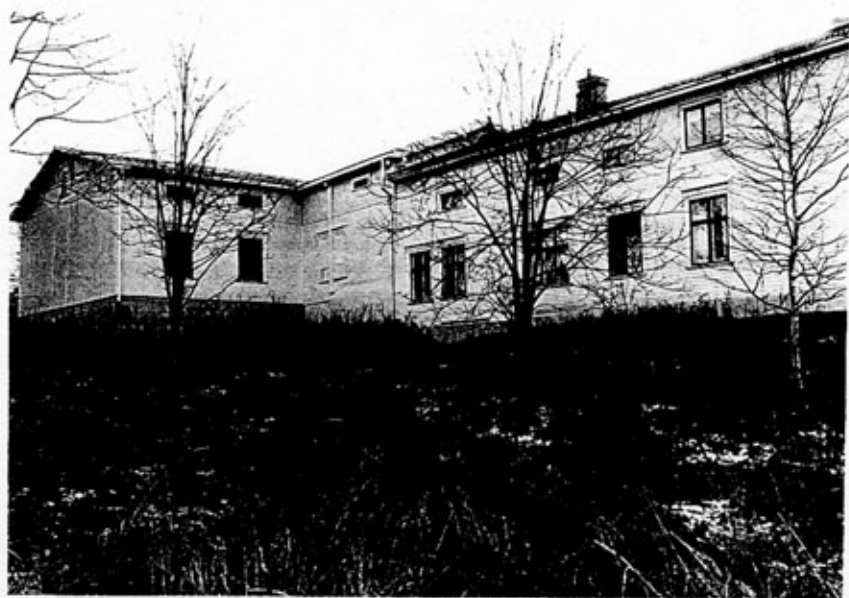
Flygelbyggnaden. Del av norra fasaden (K5401:32)
