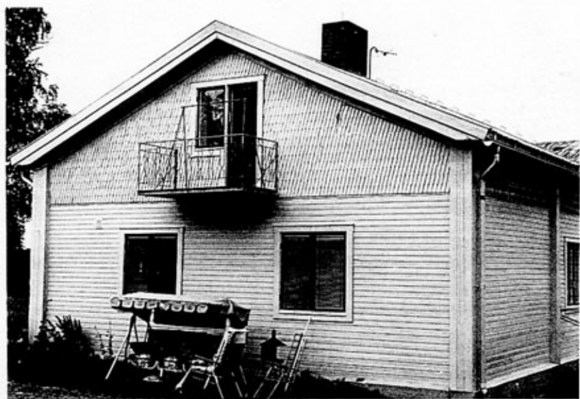
Flygelbyggnaden. Östra gaveln (K5242:27)
