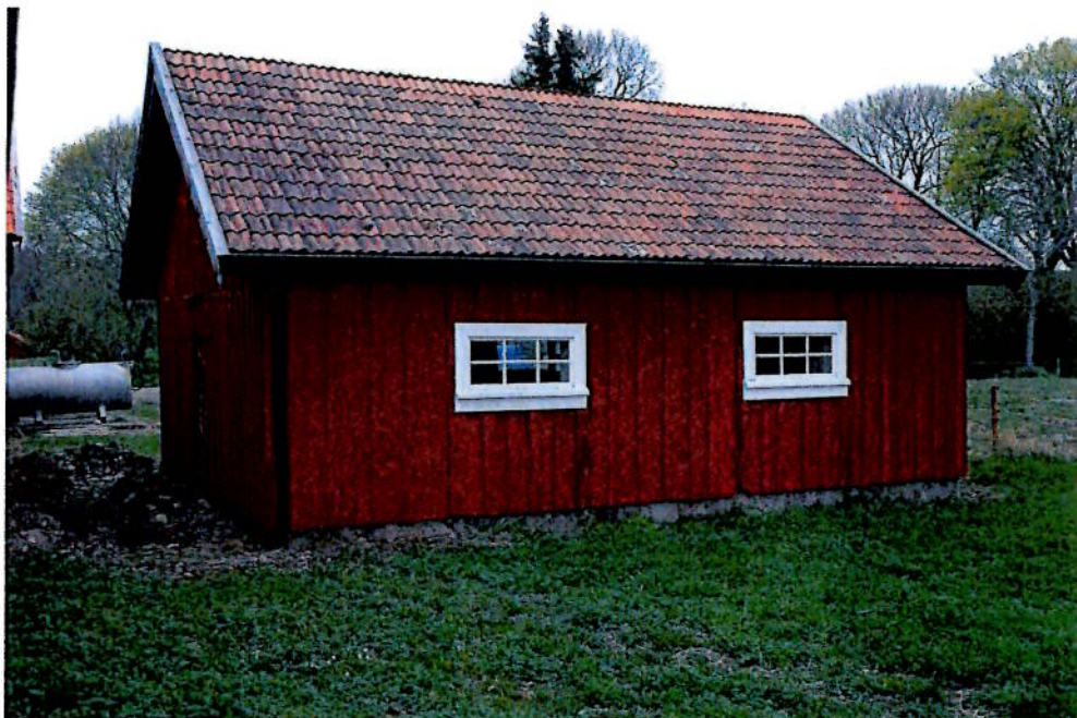
Gamla svinhuset är uppfört 1915. I början av 1950-talet gjordes det om till hönshus. Byggnaden renoverades in- och utvändigt 2002.
