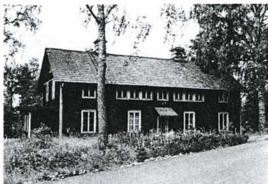
Lantarbetarbostad, kallad »Hagen två» eller »Avundsjukan». Uppförd på 1910-talet, nu obebodd. Foto 1975.
