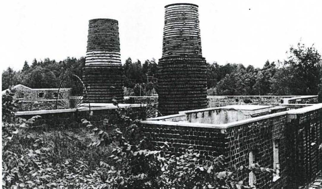
Hyttuinen i Högfors. Slaggstensmurarna står kvar, avtäckta och på en del ställen kompletterade med betong. Alla inventarier och fundament är utrivna. De två masugnspiporna står dock kvar. Foto 1975.
