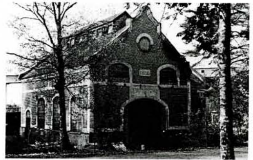
Garaget är en f.d. kraftcentral som liksom transformatorstationen är uppförd i jugendstil. Driften vid Mimergruvlave lades ner i början av 1980-talet.
