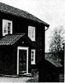
era Ett fönster na. verandan in- ansstjärna ovanför t litet fönster
