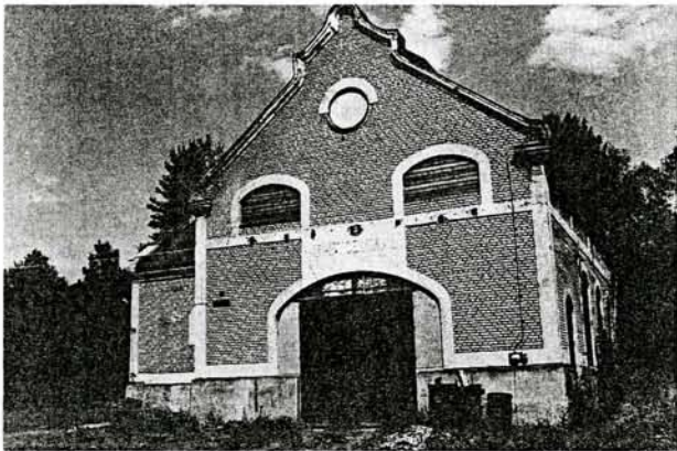
Den gamla kraftcentralen vid Mimergruvan.
