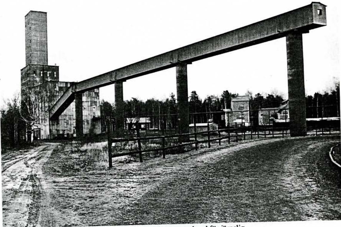
Mimergruvans lave 1986 med anrikningsverk och transportband för järnslig.
