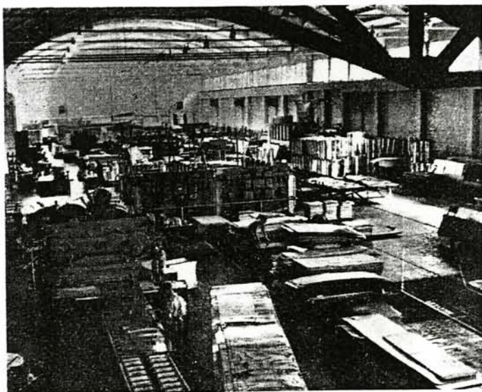
Ljusa och rena lokaler i Finspångsverkens aluminiumvalsverk.
