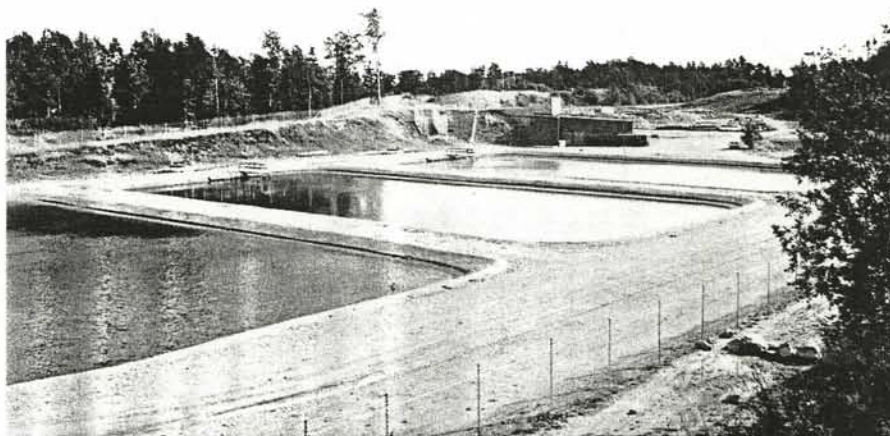
Filtreringsbassänger vid Fågelbacken. Foto: Stig Johansson.
