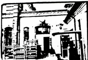
47:19 fasad NO Hörn mot SO
