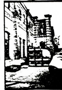
47:9 Fasad mot NO (Vy fr SO)
