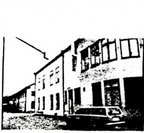
47:4 Kontorshus Vy fr SO (fasad SU)
