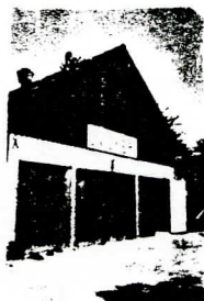
45:16 fasad SO Plåtslageri m.m.
