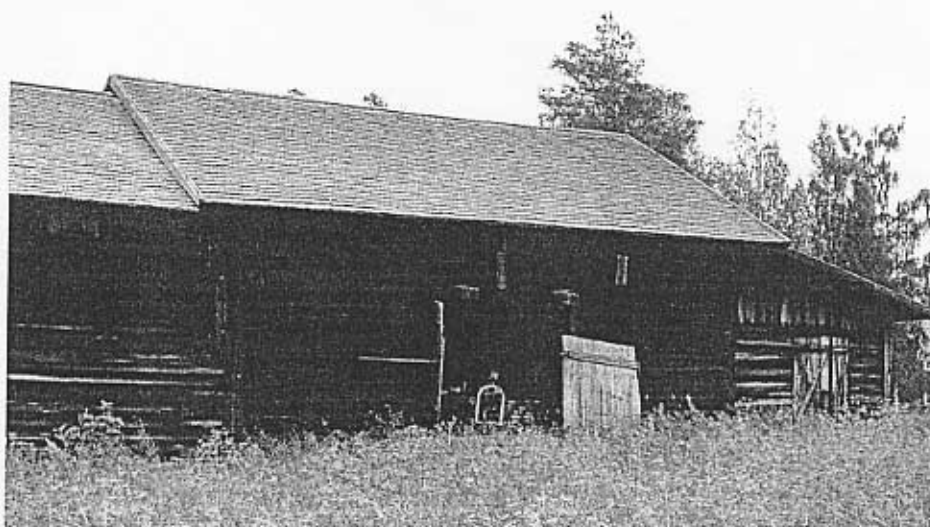
År 1825 började man tröska mekaniskt, med hästdriven tröskbult. Då byggdes den sista av gårdens tre logor. Längst till vänster i bilden ser man utrymmet för hästvandringen. Den lilla tillbyggnaden till höger är en halmbod från 1800-talets slut.
