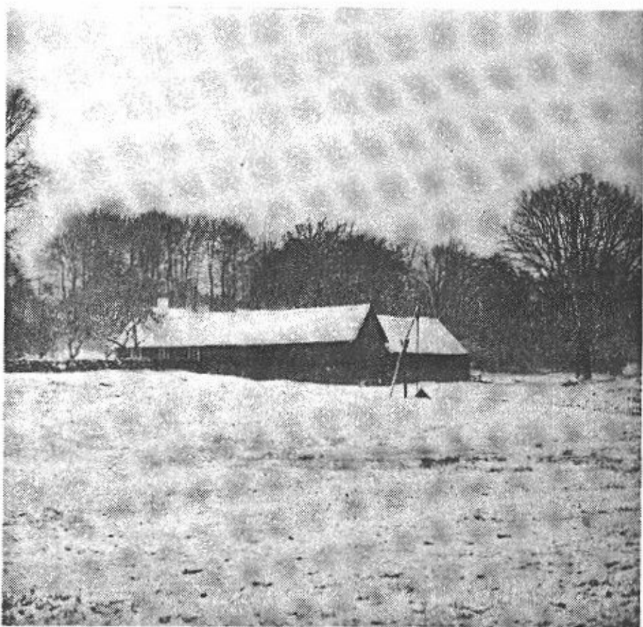
Bollaltebygget, Knäreds socken, exteriörbilder från nordost respektive sydväst. Foto: Carl-Filip Mannerstråle.
