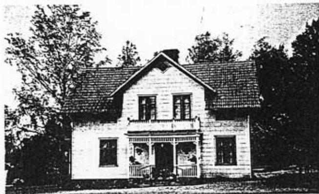
Det nyare bostadshuset (hus 6)
