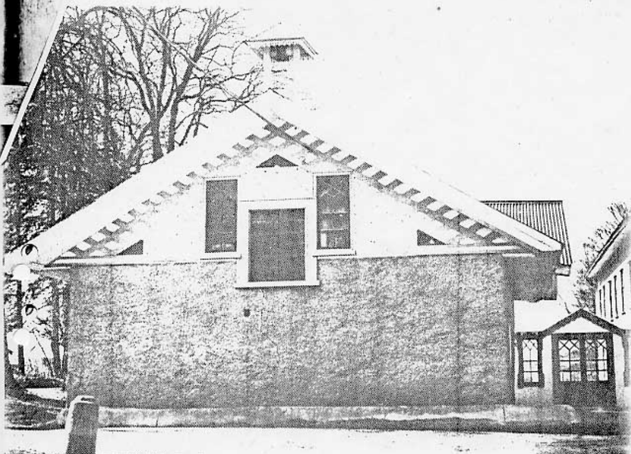
F d mejeriet från 1850-talet är uppfört i sten med gråputsade fasader
