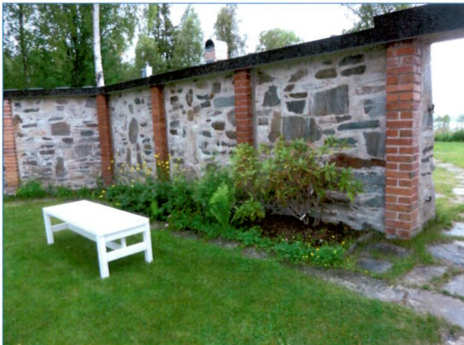
Mur med plantering. Muren ansluter till huvudbyggnadens västra fasad. Fotot visar muren mot S.
