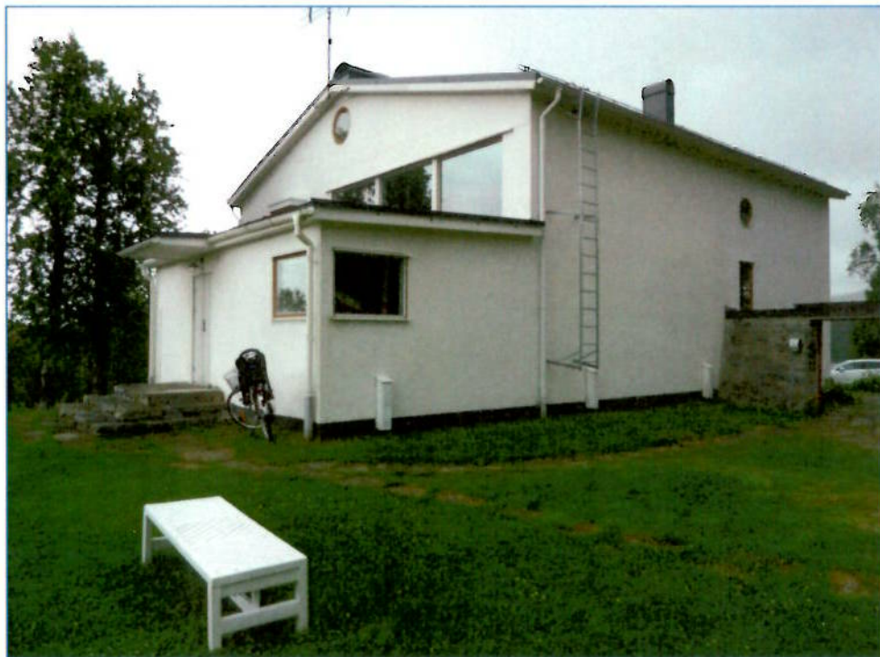
Huvudbyggnadens exteriör. Fasad mot NV.
