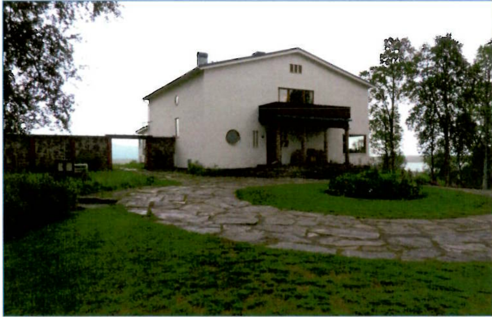
Huvudbyggnadens exteriör. Entrésidan. Fasad mot SO.
