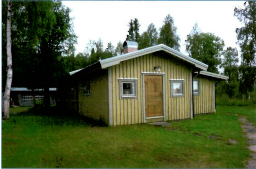
Sommarstugan/annexet. Fotot visar fasaden mot öster och byggnadens äldsta del. Den nyare, tillbyggda delen sträcker sig i stort sett från det svarta stupröret på byggnadens vänstra del och bakåt.
