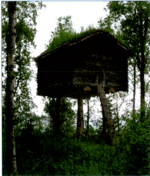
Stolpbod (Sa. njalla). Fasad mot S.
