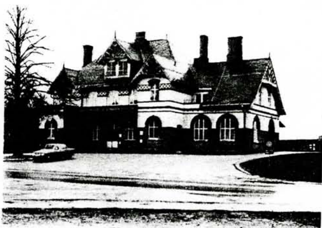
78 PRÄSTGÅRDEN 1:5 - järnvägsstation. I stationshus i tegel med mönster- bårdar i tegel, trä och puts, skiffertak, 1900. II hemlighus dito stationshuset. Arkitekten till byggnaderna tros vara Folke Zettervall. Stationsbyggnaden som bibehållit sin sekelskiftesprägel är en byggnad av stort kulturhistoriskt värde med inte- riör och exteriör i ursprungligt skick.
