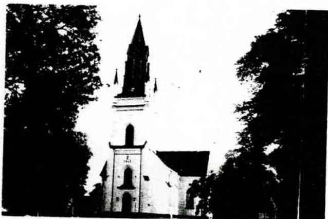
76 PRÄSTGÅRDEN 1:1 - Skinnskattebergs k:a. I kyrka, uppförd i sten, vitputsad, täckt med svart plåt, byggd 1866. Interiören renoverad 1972, exteriören 1979. Den nuvarande kyrkan ersatte en Karolinsk kyrkobyggnad. Lagskyddad byggnad.
