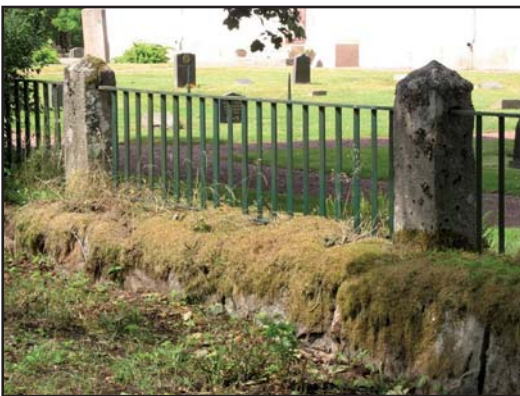
Södra kyrkogårdsmuren med smidesstaket mellan polare av sand- och kalksten.
