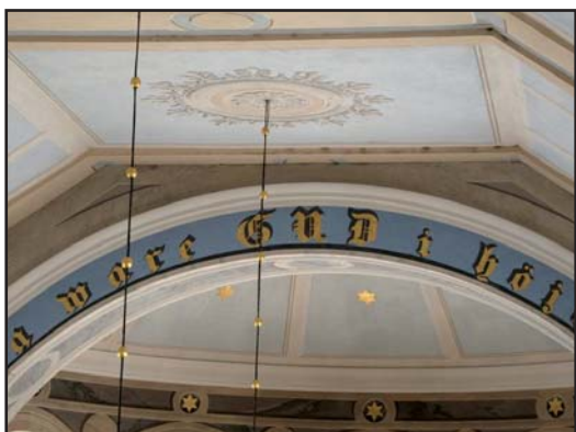
Vid restaureringen 1958 framtogs de ursprungliga dekormålningarna under tjocka lager av sot och smuts.
