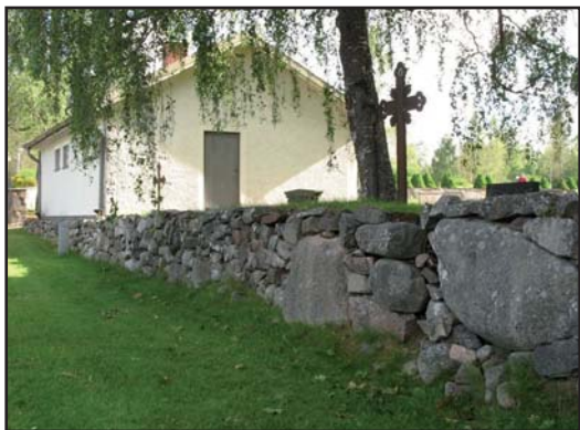
Ekonomibyggnad och mursträckning.
