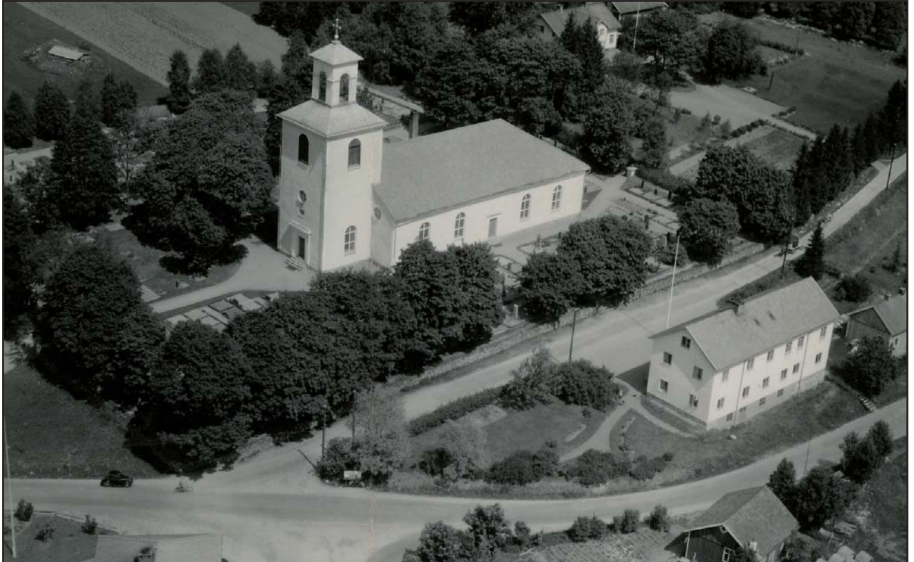
Flygfotografi från 1948. På kyrkogårdens södra del är gravarna belagda med grus och har olika inhägnad av stenram.
