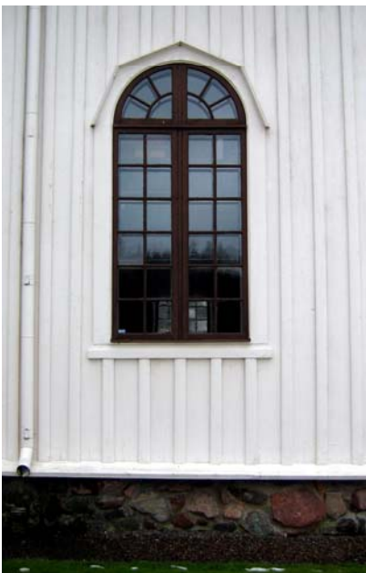
Detalj av långhusets fasad.
