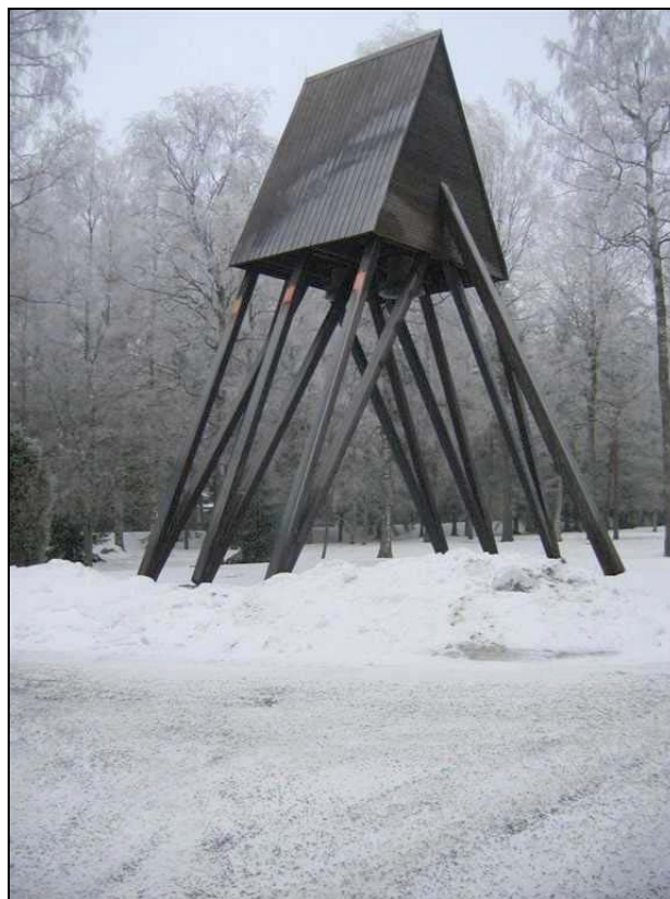
Klockstapeln hör också till skogskapellet. Med sin enkla konstruktion är det väl anpassat till byggnadens temperament.
