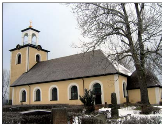
Kyrkan mot söder. Den gula färgsättningen tillkom i slutet av 1960-talet.
