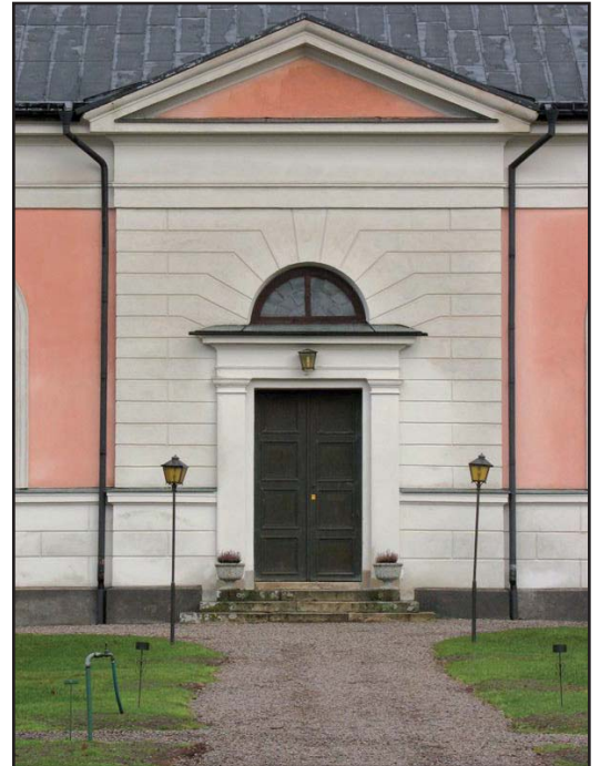
Mittportens s.k. risalit innehåller flera av empirestilens favoritelement: pilastrar, tempelgavel och lunett. Kvaderrustiken bildar en kontrast mot murlivet och framhäver portalen.
