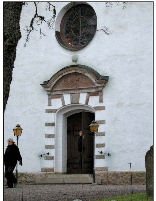
Kalkstensornamenten kring västporten är det enda som idag är synligt av tornets fasaddekor från 1902.
