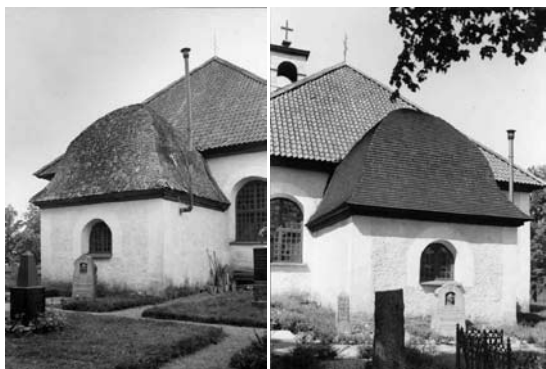
Sakristian före och efter takomläggning. Fotograf okänd, ca 1950, ur ATA
