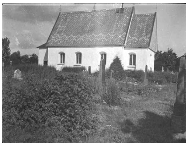
Kyrkan mot söder, fotot är taget 1934 och den mönsterlagda takbeläggningen syns tydligt. Foto av Erik Lundberg.
