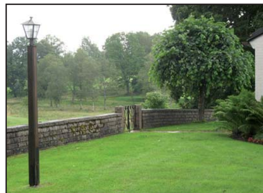
Fogad kvaderstensmur från 1968 längs nordsidan.
