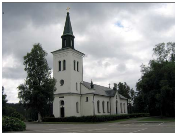
Vy av kyrkans norra och västra fasader.
