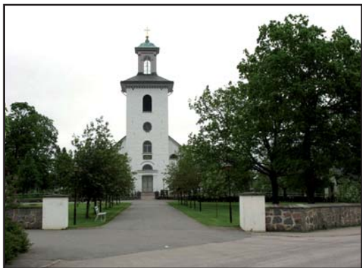
Infarten i väster med grindstolpar och murar från 1961.
