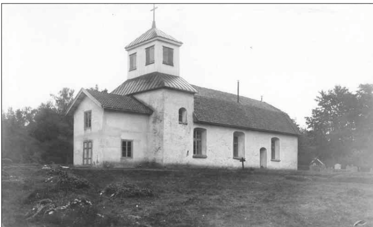
Kyrkan fotograferad 1923 visar det höga vapenhuset som revs vid restaureringen 1942. På bilden finns även den södra porten. Foto Dan Samuelsson 1923. (ATA)
