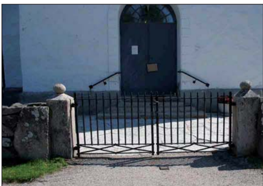
Den omgärdande stenmuren växlar mellan fristående och stödmur.
