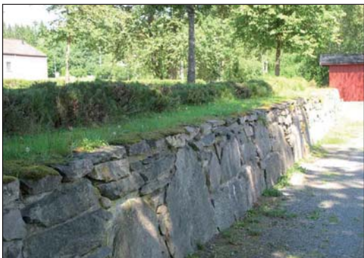
Den omgärdande stenmuren växlar mellan fristående och stödmur.
