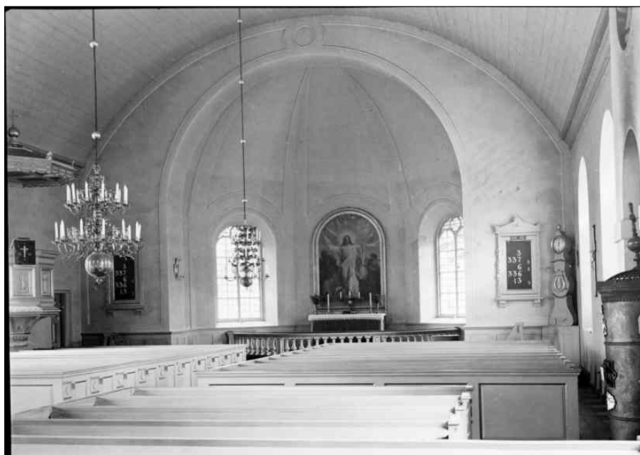
Ett foto av kyrkan taget innan den elektriska uppvärmningen installerades 1954 visar en av de kaminer som användes för kyrkans uppvärmning.
