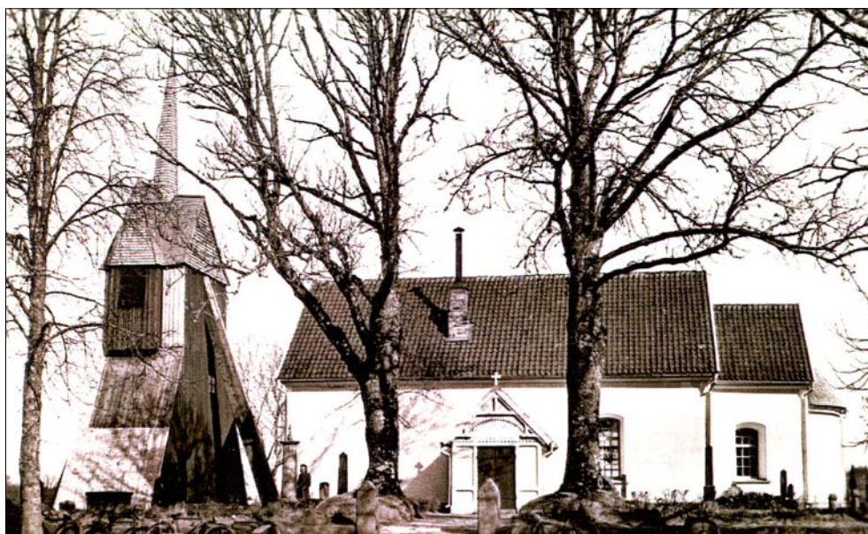
Klockstapeln under reparation. Troligen från 1930 talet. (JLM)
