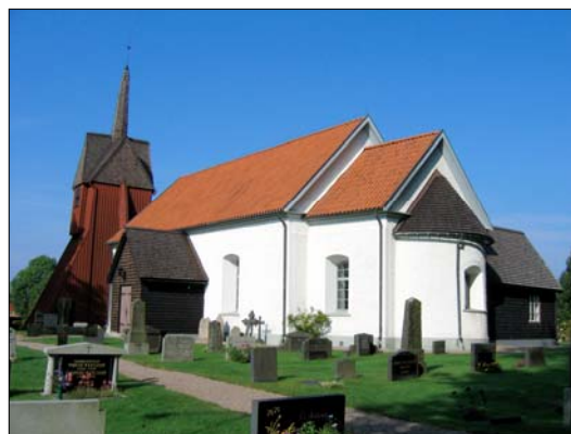
De exteriöra åtgärder som utförts på senare år har syftat till att ge kyrkan ett mer medeltida uttryck.
