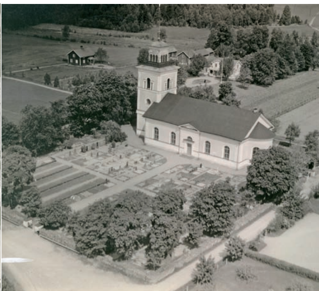
Kyrkogården 1947-49. Nu har kvarter E fått längsgående grusgångar och rygghäckar. Kvarter F är dolt bakom grönskan. Foto: AB Flygfoto
