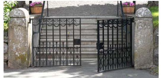
Grind från 1836 (mot kyrkans västentré)
