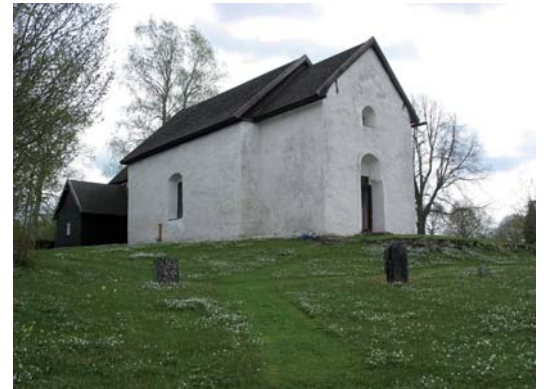
Norra och västra fasaden av kyrkan.
