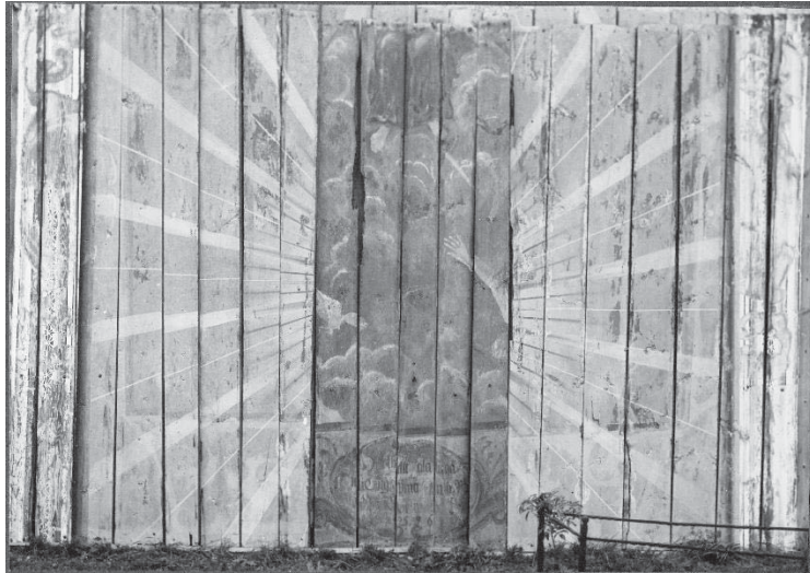
Takmålningen i långhuset under framtagning, det klassicistiska strålomkransade ögat från 1820-talet har tvättats bort och mittpartiet på 1700-tals måleriet har frilagts. Foto: Sven Wahlgren 1950. ATA
