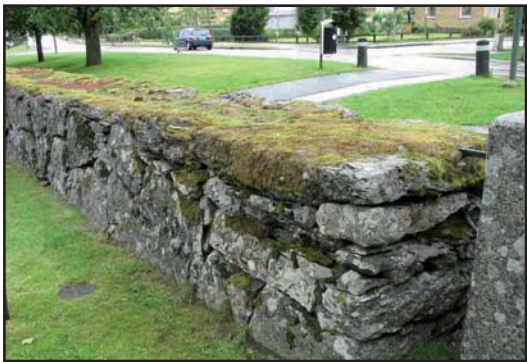
Den stenmur som omgärdar kyrkogården är kallmurad runt den gamla delen och fogad med cement runt utvidgningen i söder.
