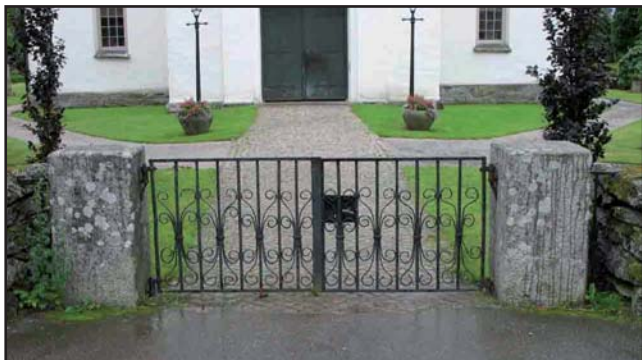
Den norra ingången till vänster och den sydvästra till höger.
