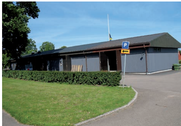
Ekonomibygnad med vaktmästeri.
