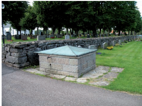
Fyrkantiga brunnskar uppmurade av kalksten finns i kvarteren U och V vid västmuren. Brunnskaren ska avlägsnas inom snar framtid.
