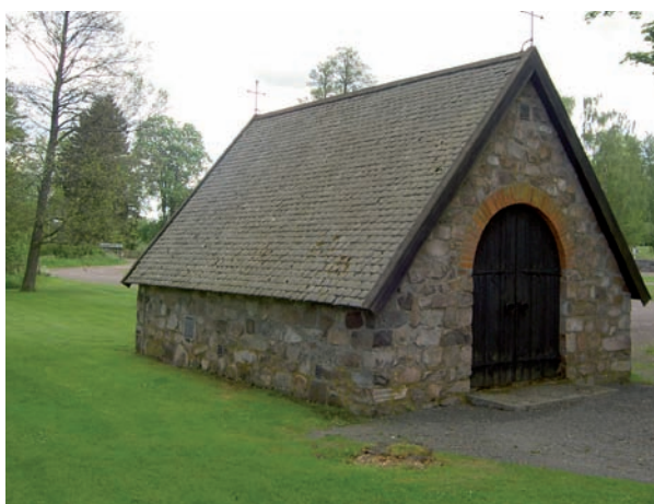
Bårhuset som uppfördes 1955 och som är ritat av länsarkitekt Hans Lindén.
