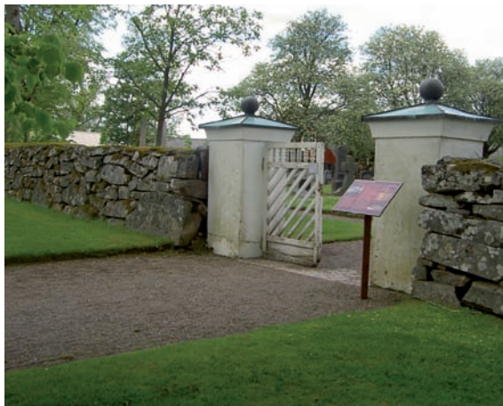
Ovan: Huvudingången till den gamla kyrkogården. Mellan två uppmurade och putsade stolpar finns en dubbelgrind i trä.
