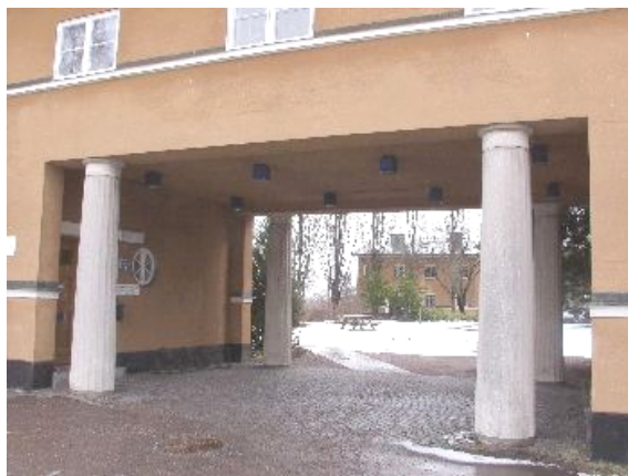
Portalen i fasadens mitt förenar båda flyglarna och markerar ingången till anläggningens inre gård. I bakgrunden kyrkobostället, ett av de två bostadshusen som sluter gården på södra sidan.
