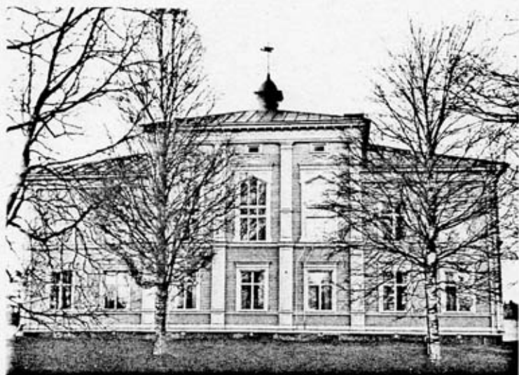
C 311:3 Fasad mot Tingsvägen från NÖ.
