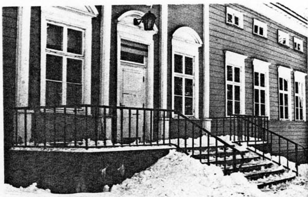
Huvudbyggnadens entré mot norr
