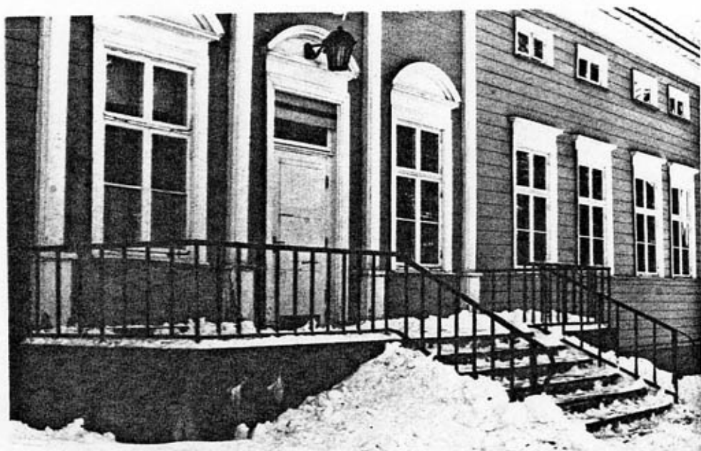
Huvudbyggnadens entré mot norr
