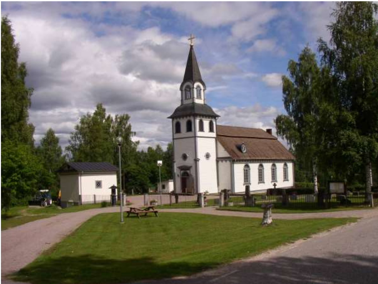
Voxna kyrkomiljö från sydväst med från vänster; gravkapellet, ekonomibyggnaden (gaveln) och kyrkobyggnaden. Foto: Daniel Olsson, Länsmuseet Gävleborg, 2004-07-07.
