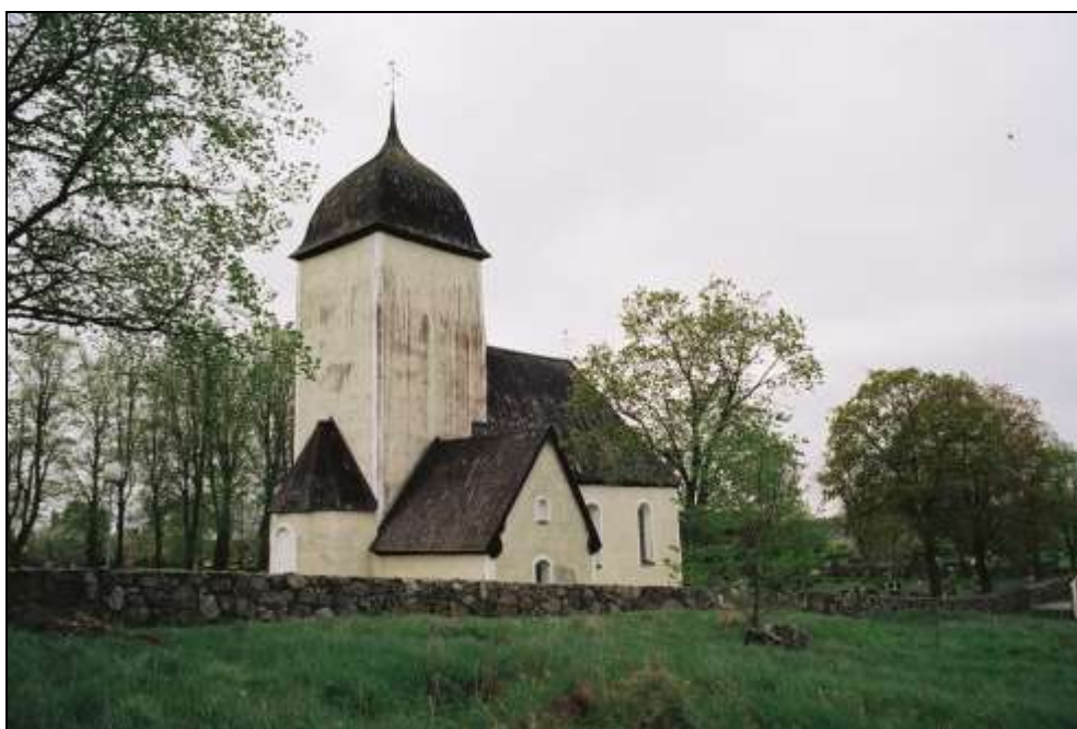
Husby-Ärlinghundra kyrka med långhus, torn med 1700-talshuv, absid och sakristia åt norr omgärdat av bogårdsmur. Alla taken är täckta med spån. Foto: Lisa Sundström, maj 2004.
