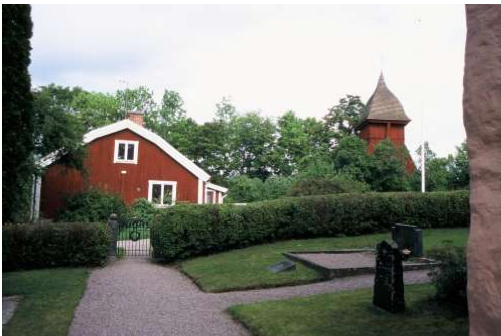
Öppning i kyrkogårdsmuren mot norr och klockargården, numera kyrkväktarns bostad och församlingshem samt klockstapeln nordost om kyrkan. Foto Gunilla Nilsson 2003.
