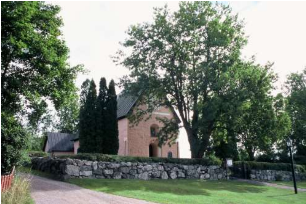
Haga kyrka från nordväst med sakristian, kyrkans äldsta del, samt västfasadens portal från 1780-tal. Foto Gunilla Nilsson 2003
