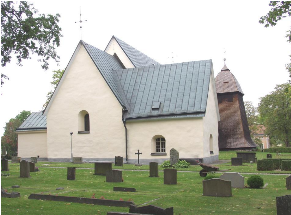
Gravkorets norra sida, korets östra gavel och sakristia; i bakgrunden ses klockstapelns som är klädd med spjälkade spån. Bortom denna skymtar det f d skolhuset. Digitalfoto Rolf Hammarskiöld
