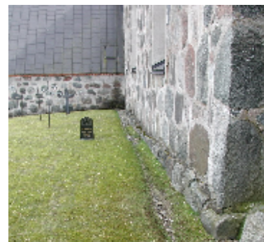
Långhusets norra sida och sakristians västra takfall - Digitalfoto Svensk Klimatstyrning AB
